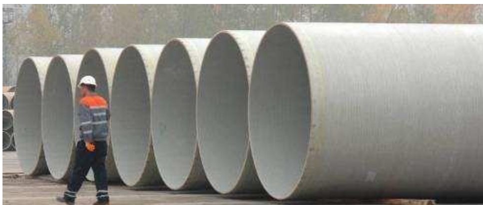
Rysunek 4: Składowanie rur na jednym poziomie
