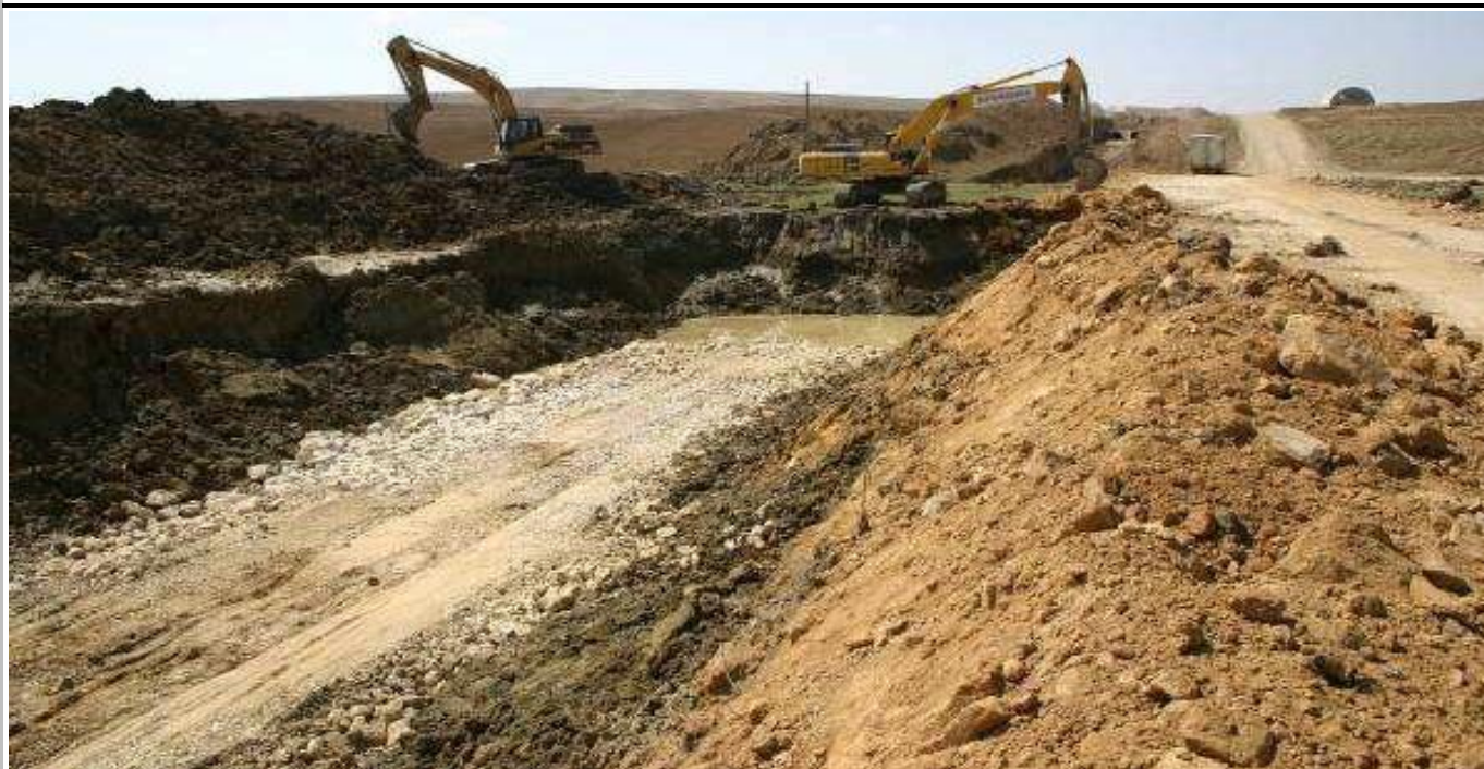
Prace stabilizacyjne podłoża wykopu (fundament)
